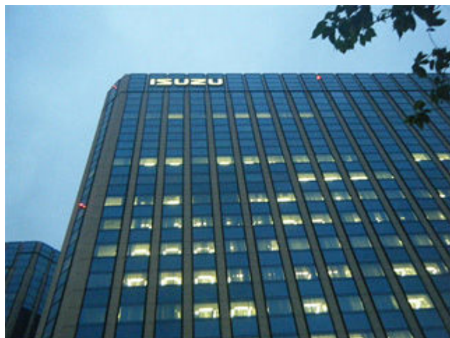
ISUZUサイン看板点灯中
