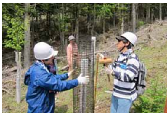
鹿害を防ぐ鹿除けネットの取り付け
