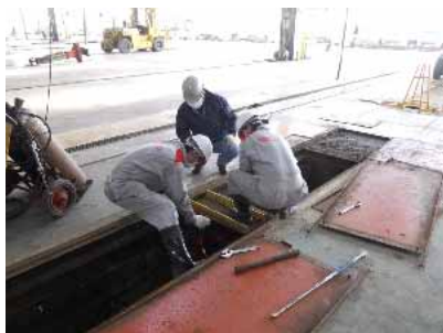
リフトの取り外し
