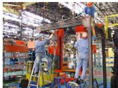
リフトの修理
