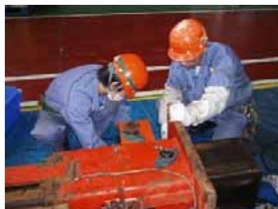
リフトの修理
