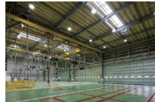
LED照明を採用した整備場
