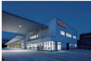
LED照明を採用した新拠点
