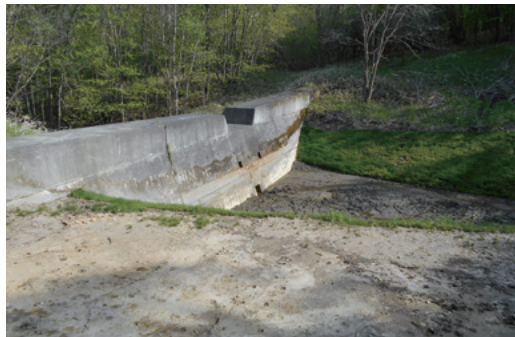
構内に設けられた砂防ダム
