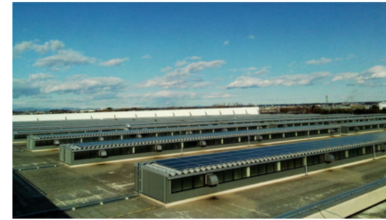
栃木工場の太陽光発電設備
