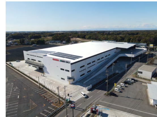
2020年4月に稼働を開始した「いすゞロジスティクスグローバルセンター」
